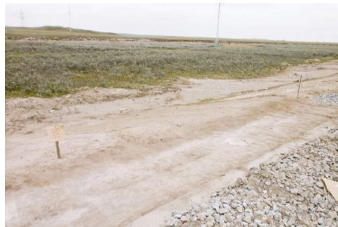
Откос и обочина насыпи после обработки
