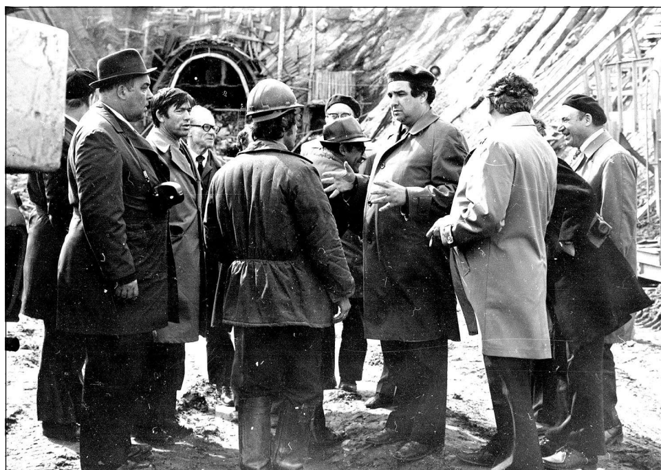
— Члены Научного совета АН СССР по проблемам БАМ на строительстве Нагорного тоннеля (фото В. Новикова)
