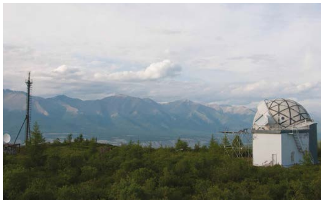
Большой врезатменный солнечный коронोगраф — уже существующий прибор, предназначенный для исследования короны Солнца и хромосферы. На фотографии он ориентирован по ноябрьскому положению светила. Расположен в Саянской солнечной обсерватории (п. Монды, Бурятия)
