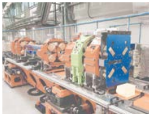
Монтаж гирдерной сборки
