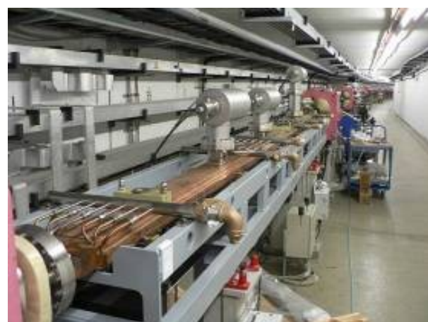
Рис. 56. «Змейки» (вверху) и приемники излучения (внизу), установленные в тоннеле PETRA III.
